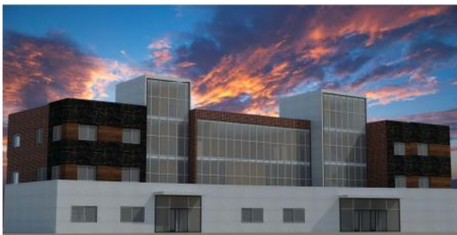
تصویر ۶. نمای جنوبی ساختمان در دست احداث پژوهشکده
